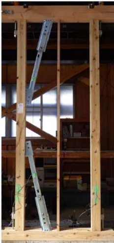
住友理工製 制震システム「TRCplus」
