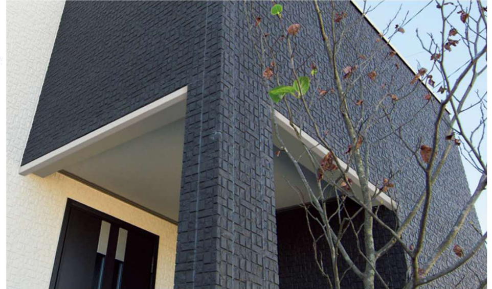
セリオスタイルV施工事例 ※色は異なります。
